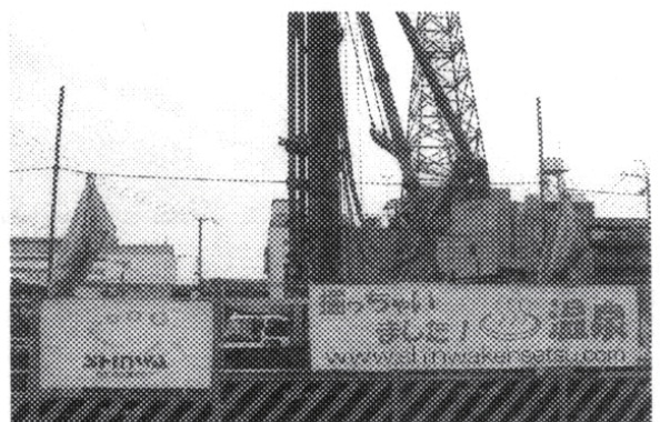
▲温泉掘削の様子
