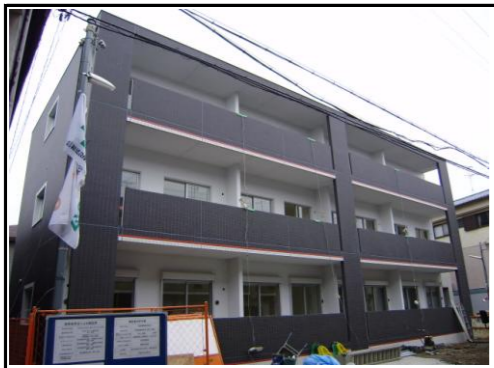
◇現在の現場写真◇
